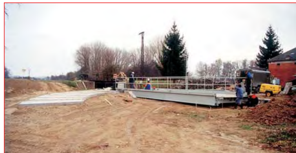
Otočný most jako celek je dopraven na stavbu
