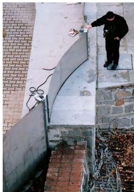
Dotlačení membrán pomocí přitlačného zařízení. Hotovo - může přijít povodeň.
