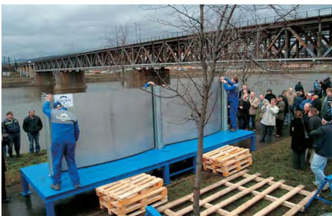
Dotáhnutí přítlačných destiček
