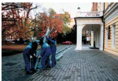
Nasazení těsnící gumy na slupici a osazení slupice do základu
