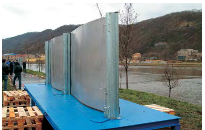
Kompletně postavené hrazení
