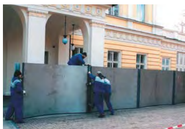
Osazení membrán do zámku slupic
