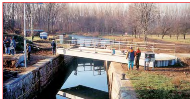
Otáčení mostu před velkou vodou nebo před proplutí lodě
