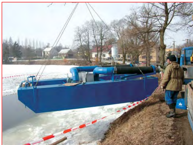
Pomocí jeřábu je prám sejmut z korby
