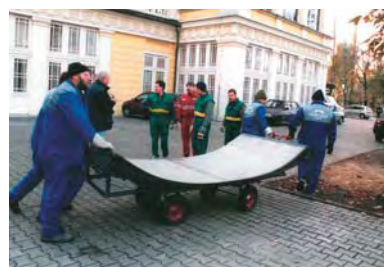
Rozvoz slupic a membrán na místo montáže
